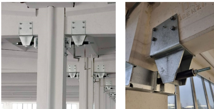
Esempi di collegamento dissipativo trave-pilastro con Sismocell
